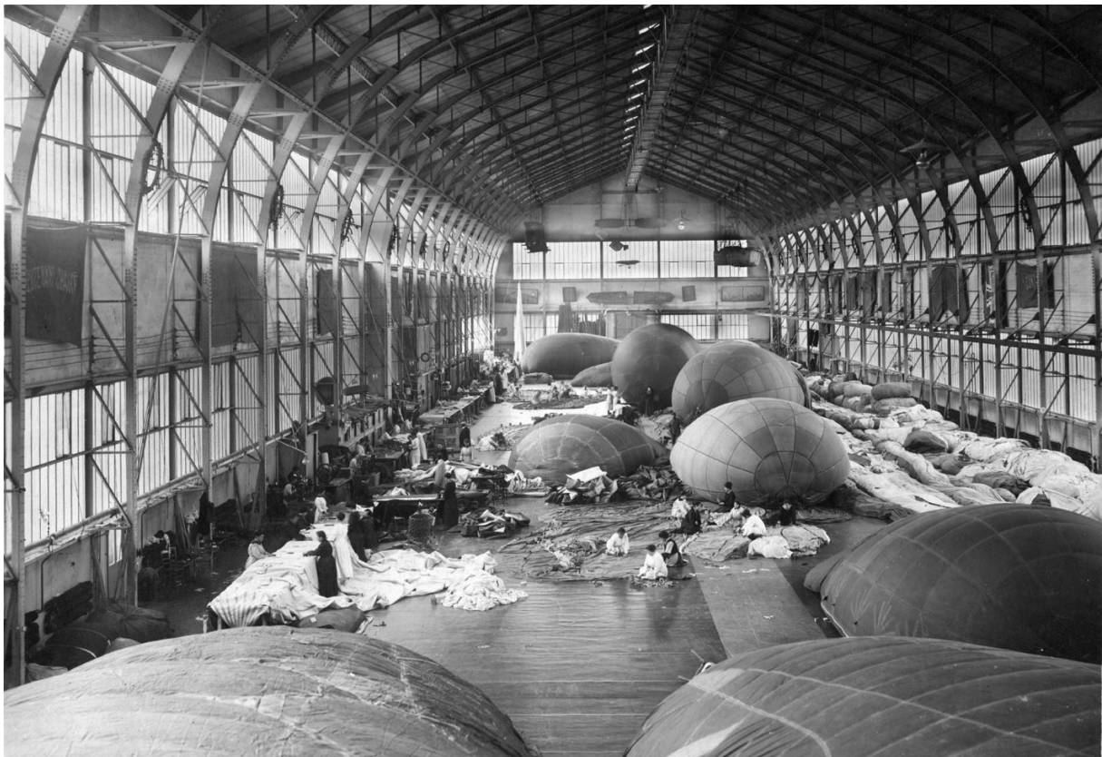
Figure 2 : La construction des ballons dans le Hall AT de Chalais-Meudon
